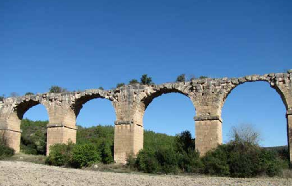
Keriz Köprüsünün sağlam kalan altı ayağından beşi (Altıncı ayak sol uçtadır ve kemeri yıkılmıştır.)
