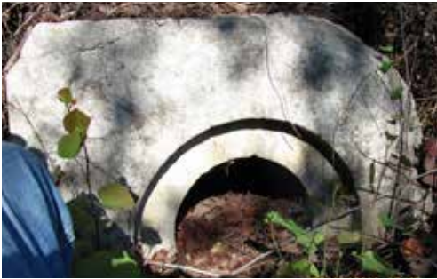
Köprü'nün, suyun akışına göre sağ yanında bulunan ve aynı zamanda korkuluk görevi de yapan kanal blokunun setli yüzü
