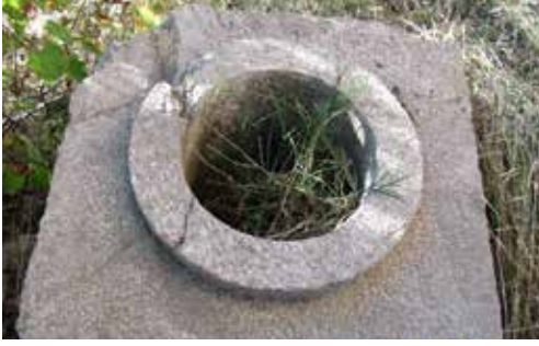
Keriz köprüsünün üzerinden su taşıyan kanal taşlarından birinin yivli yüzü.
